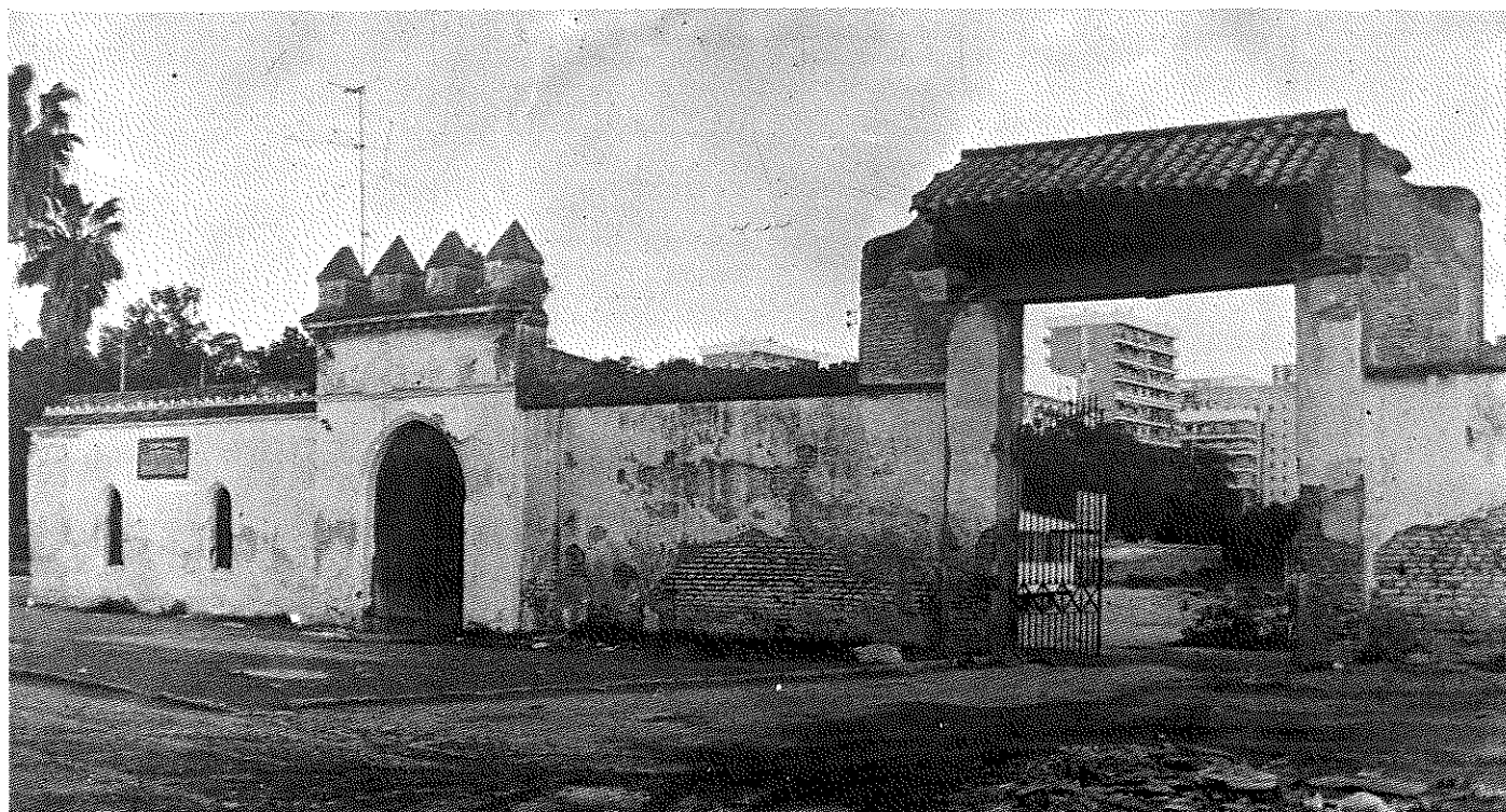
Estado actual del acceso a la Huerta del Rey.
