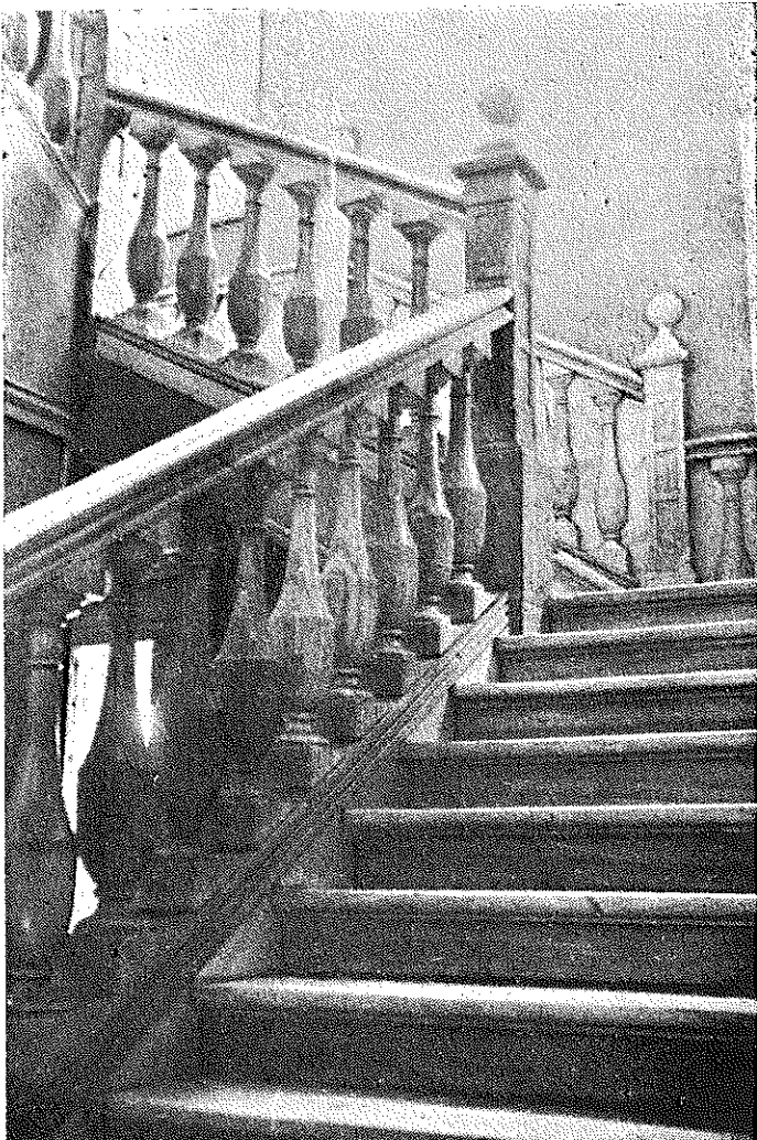
Escalera principal de acceso a la galería alta.
