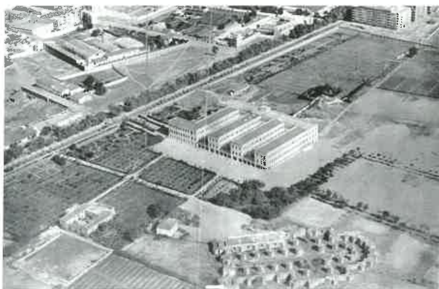
Foto aérea antigua de Portaceli. El edificio más cercano al ángulo inferior izquierdo es el actual centro cívico de la Buhaira. Abajo a la derecha, lo que se construyó de la basílica.
