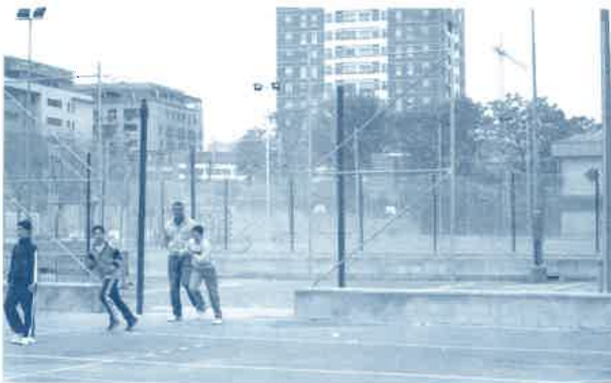
Se han instalado redes metálicas para evitar salidas del balón de los terrenos de juego.
