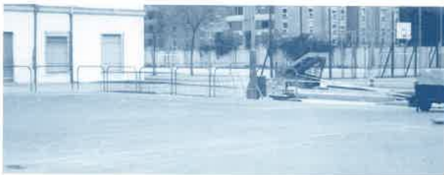
Una instantánea de los terrenos antes del arreglo.
