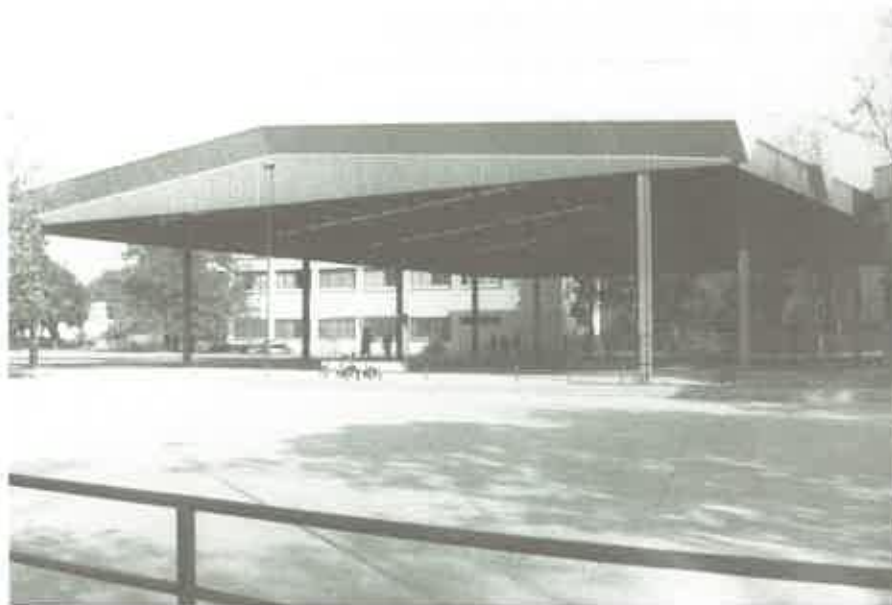
Una de las máximas aspiraciones del Colegio ha sido siempre tener un polideportivo cubierto. Esperamos que las obras iniciadas este año lleven a buen puerto esta vieja ilusión
