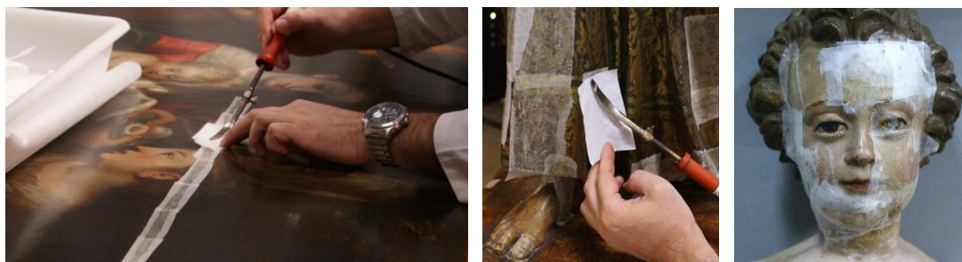
Ilustración 12: Proceso de asentado y fijación de una superficie pictórica.
