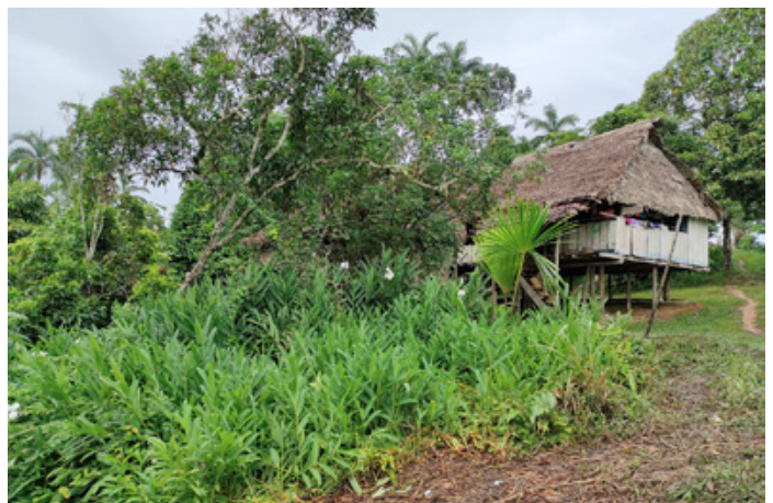
Las casas se construyen en alto para evitar la humedad y los animales
