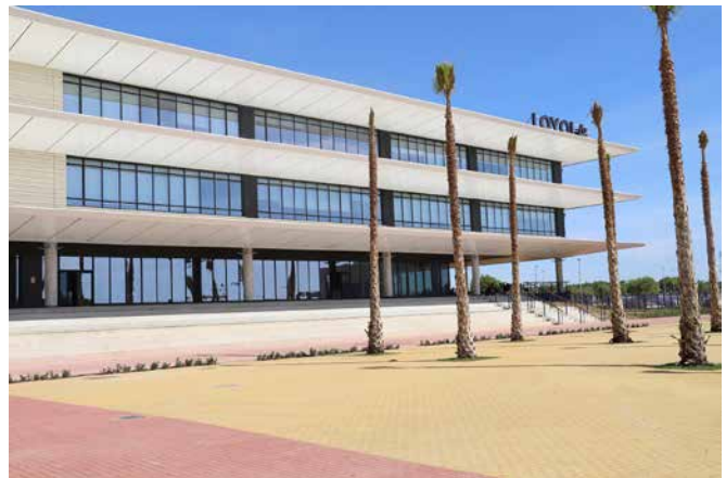
Vista de la fachada Sur del edificio principal desde la plaza
